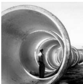
「全国水道網」のコンクリートパイプの断面 (直径108インチ)
